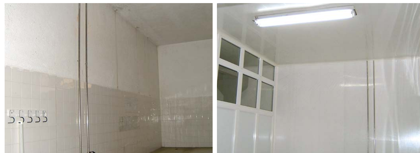
Sala Blanca antes y después de la instalación de panel sanitario.
