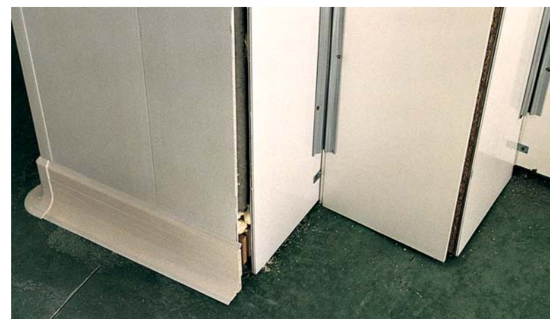
Montaje p.v.c. blanco extrusión con perfiles sanitarios.
