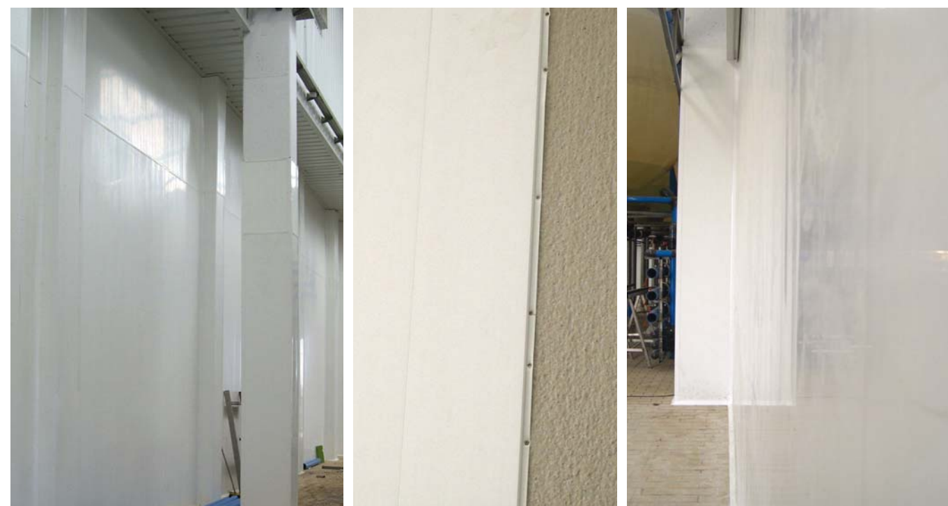
Diversas fases de la instalación con panel sanitario.
