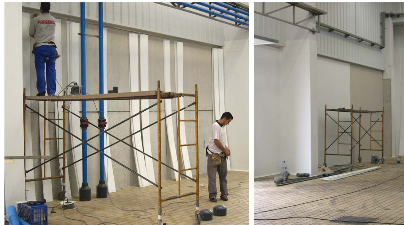
Sala Blanca antes y después de la instalación de panel sanitario.
